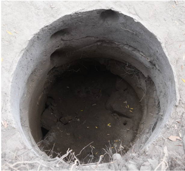
Fig. 26. Cisterna B dopo la rimozione del riempimento.
