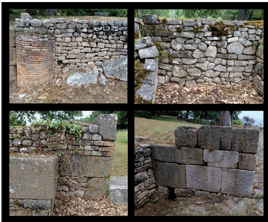
Fig. 4. Campionatura delle tecniche murarie messe in opera nel santuario di Rossano. (Autrice).
