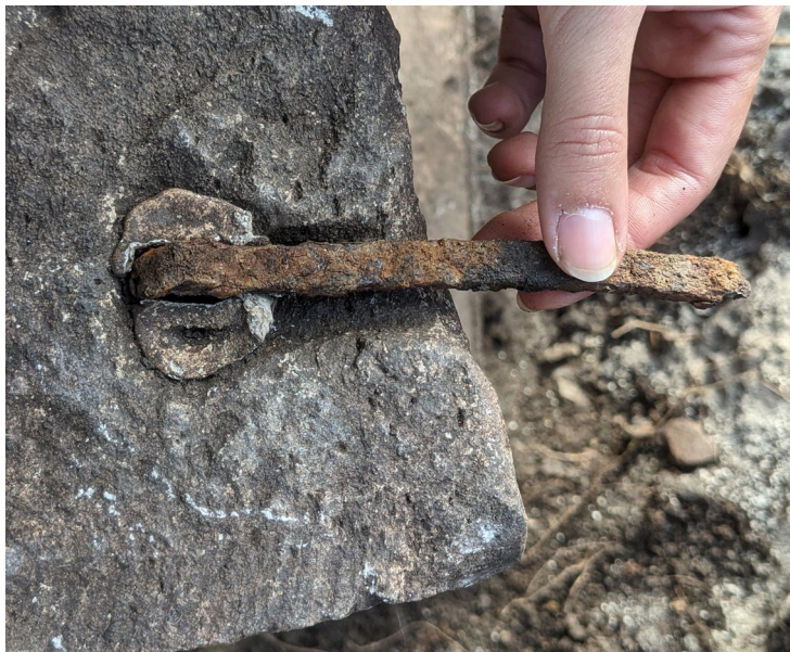
Fig. 30. Grappa di ferro RP 20 riposizionata in uno dei due cavi presenti sul lato superiore del blocco iscritto RP 19 (foto D. Diffendale).
