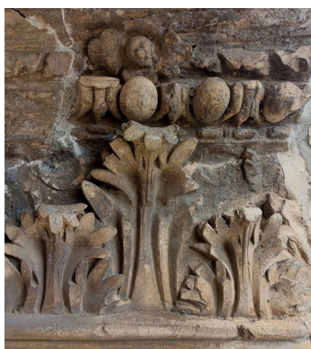
Fig. 19. Pompei, Casa degli Amorini Dorati. Dettaglio della decorazione del capitello del pilastro nord dell'edicola (foto autore; © MIC-Parco Archeologico di Pompei).
