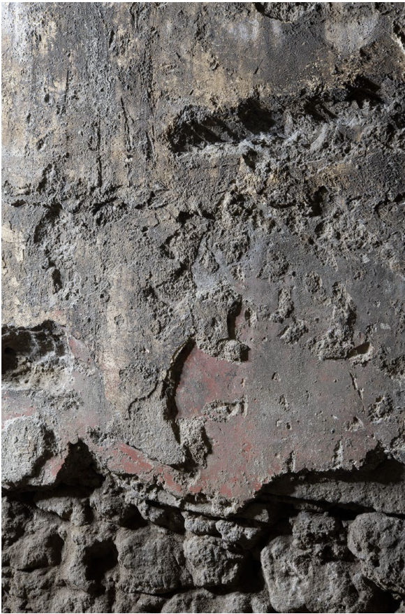
Fig. 3. Criptoportico, muro ovest, successione degli intonaci (foto di Luigi Spina).
