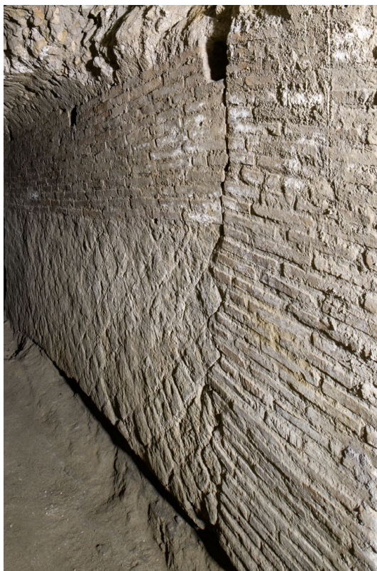
Fig. 30. Forno 1: particolare degli alloggi per i becchi dei mantici (foto di Luigi Spina).
