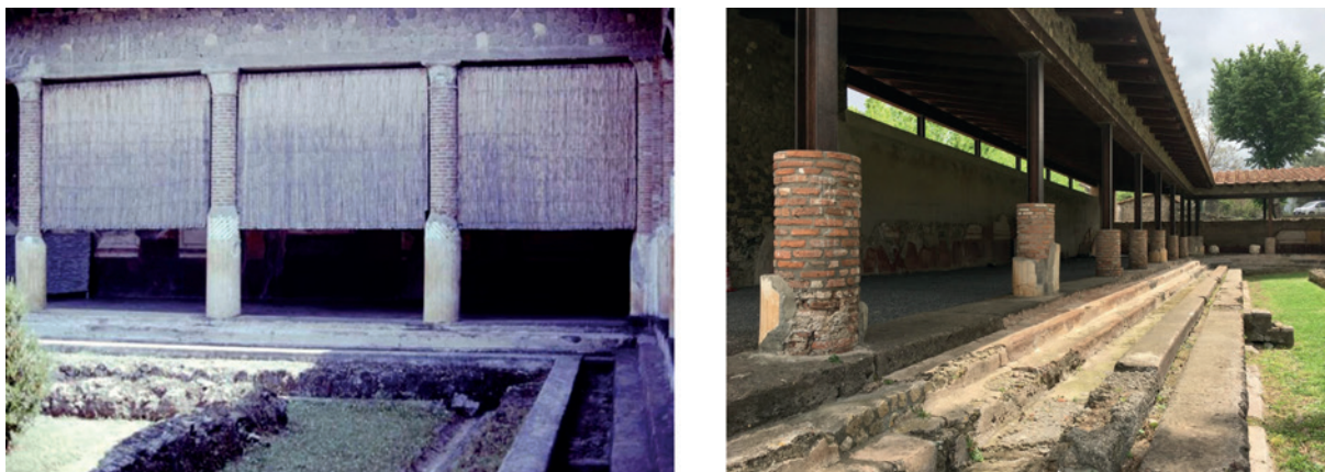
Fig. 12. A sinistra il braccio nord del peristilio superiore prima del terremoto del 1980. Si notino i lavori di ricostruzione novecenteschi e la disposizione di stuoie per la protezione degli affreschi dall'irraggiamento solare, foto 1976 (da https://pompeiiinpictures.com ); a destra lo stesso ambiente come si presenta oggi dopo i restauri del 2012, che hanno previsto un intervento fortemente invasivo con elementi in ferro inseriti nei tronchi delle colonne superstiti, da sostegno al tetto realizzato con impalcato in legno lamellare e manto di tegole e coppi (foto dell'autore, 2019).
