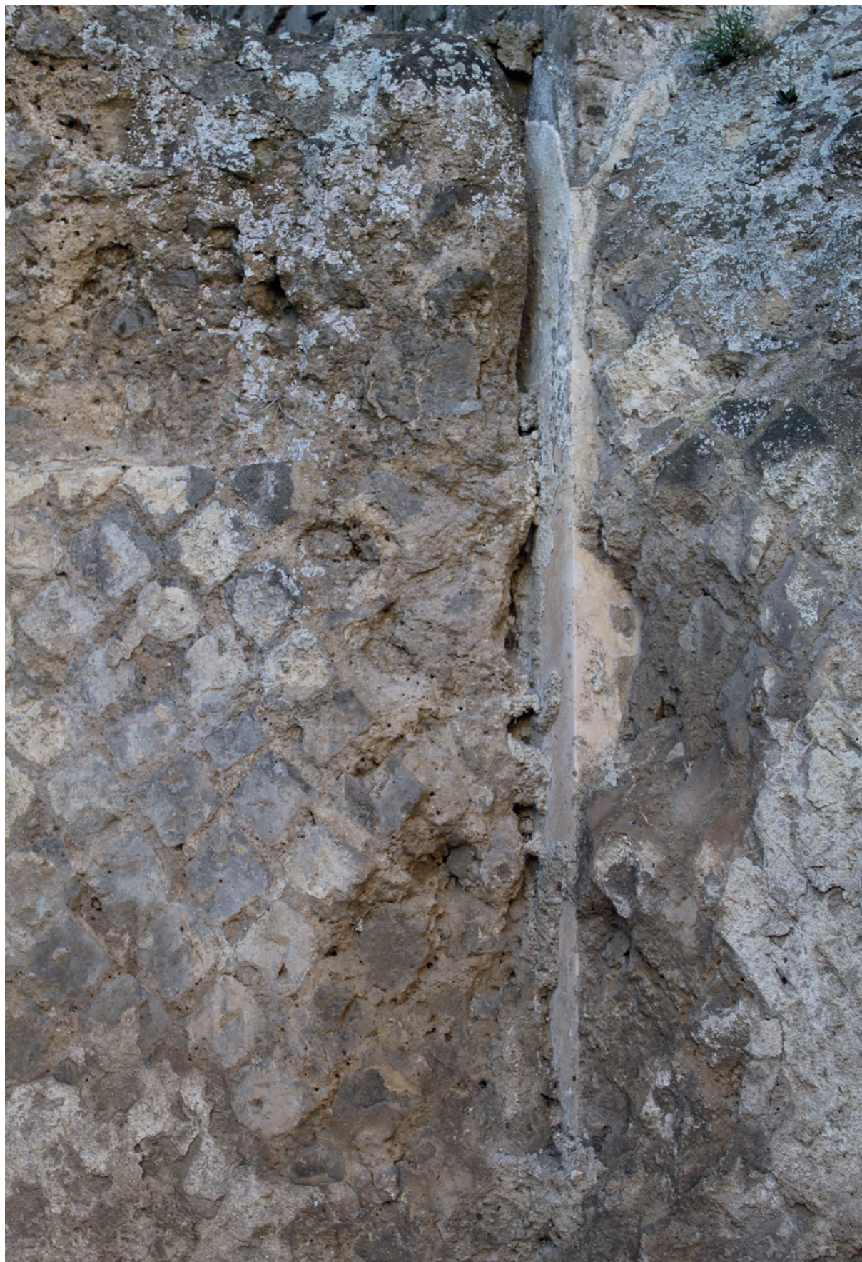
Fig. 6. Particolare del rapporto stratigrafico murario che intercorre tra l'abside dell'ambiente [42a] e il muro perimetrale est del corridoio [31].
