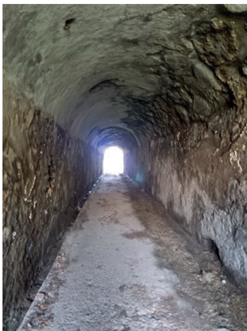
Fig. 13. Galleria di Villa Arianna che collega la villa alla parte bassa della collina.
