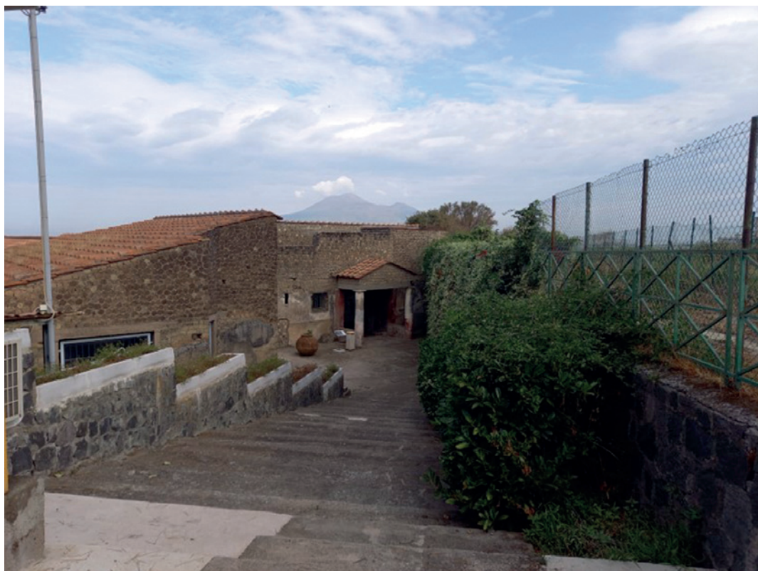
Fig. 6. Area di accesso a Villa San Marco.
