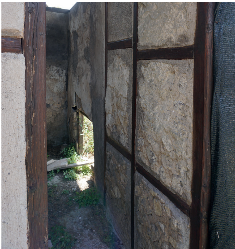
Fig. 8. Pareti in opus graticium negli ambienti in prossimità dell'ingresso nord della villa.
