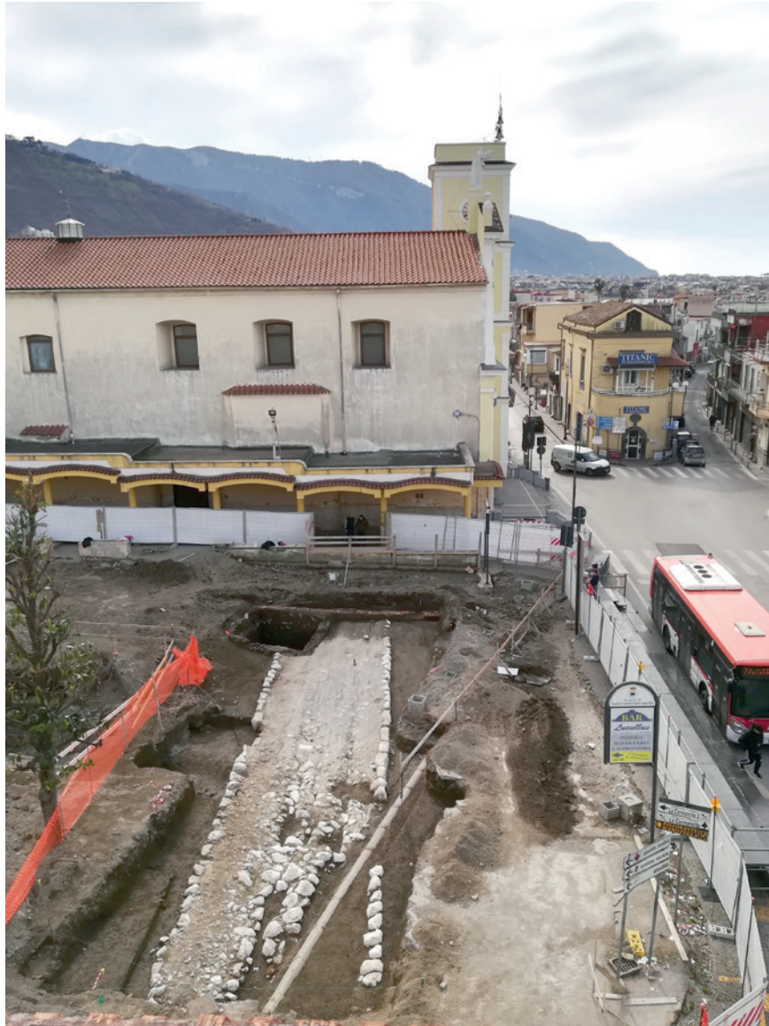
Fig. 3. Sant'Antonio Abate: foto generale dello scavo da NO.
