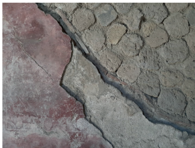
Fig. 5. Dettaglio della linea di sutura impiegata nelle ricostruzioni degli anni Cinquanta e Sessanta del Novecento.
