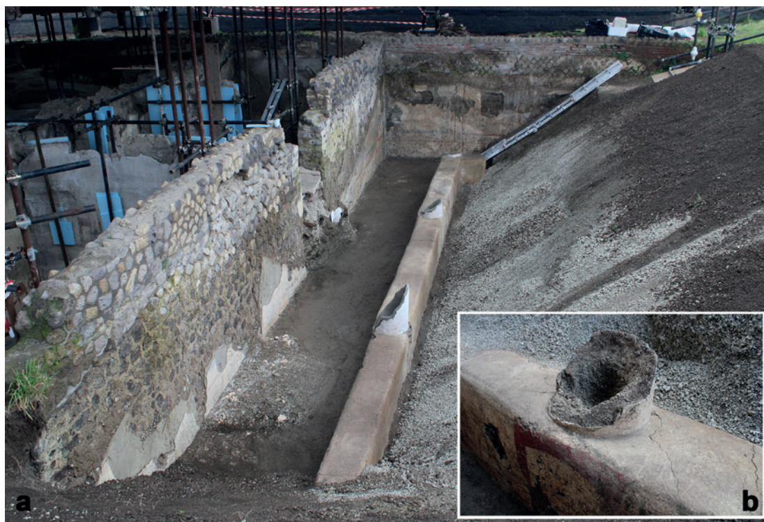
Fig. 10: Villa San Marco, scavo 2020-2021: (a) porticato [90] sul quale si affacciano i nuovi ambienti [83],[84],[85]; (b) dettaglio delle colonne in opus craticium .
