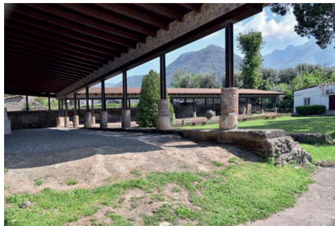
Fig. 3-4. Confronto tra l'assetto del peristilio superiore nel 1961 e l'attuale configurazione dovuta ai restauri e alle ricostruzioni post sisma del 1980.
