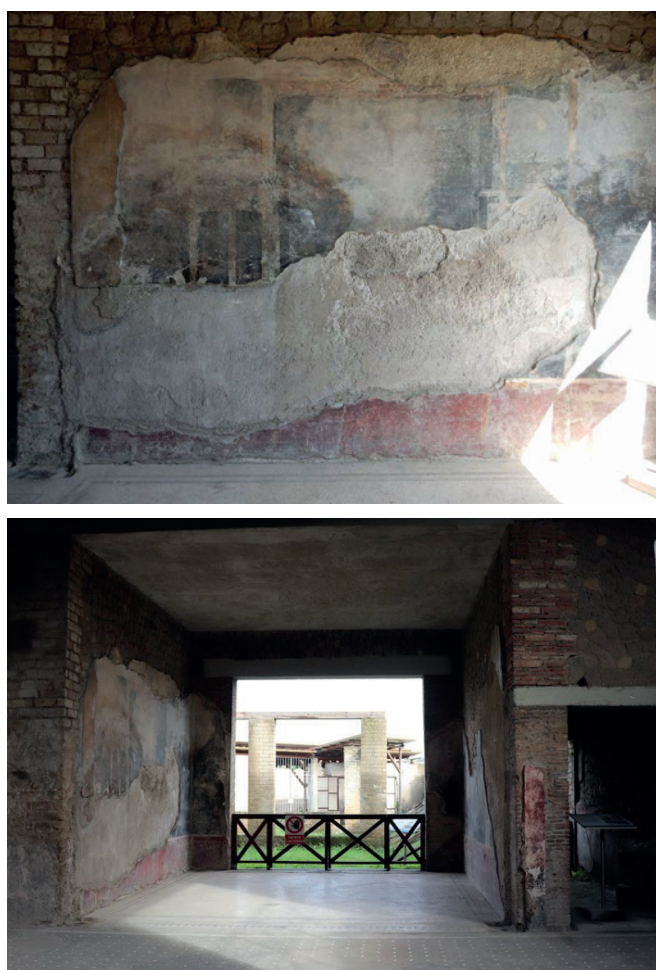
Fig. 7-8. Particolare della parete ovest affrescata dell'ambiente 59, il tablinum aperto verso il porticato nord di villa san Marco.
