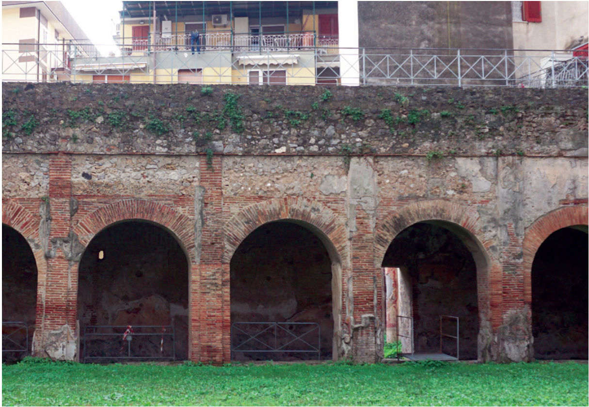
Fig. 16. Ala sud del porticato del viridarium . Particolare linea riflessata e della porzione di muratura ricostruita.
