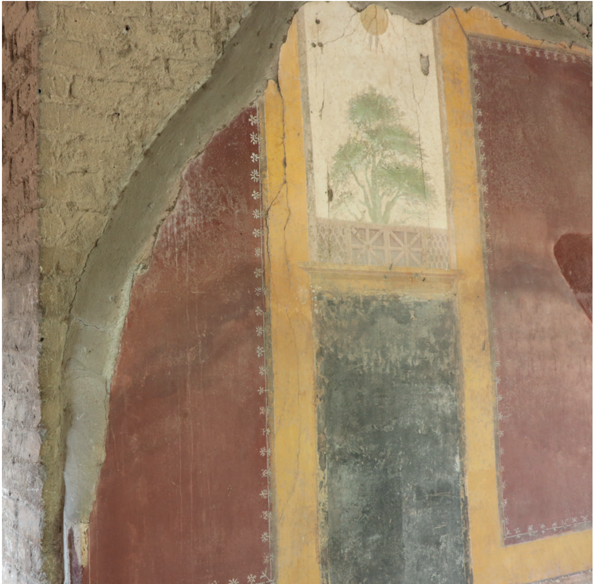
Fig. 7. Stuccature di bordo in malta cementizia applicate negli anni Cinquanta per il consolidamento dei lacerti di intonaco (foto dell'autore 2019).
