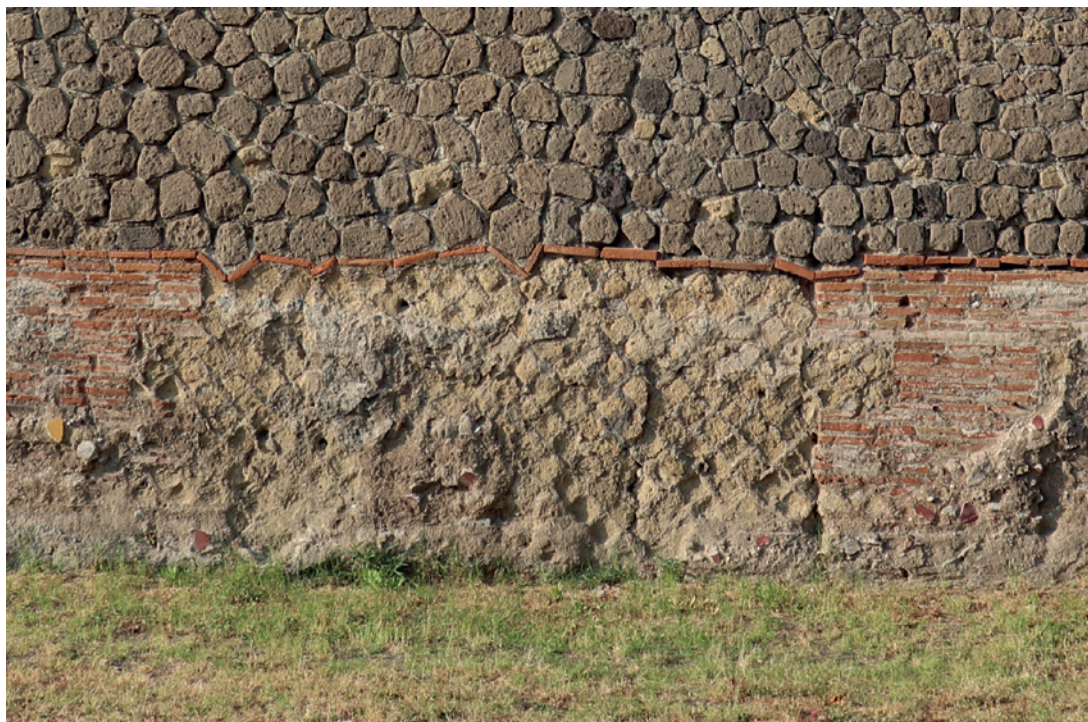
Fig. 5. Parete settentrionale dell' oecus posto ad ovest. Ben si distinguono nel paramento in opera reticolata le “catenelle” in mattoni utilizzate per consolidare le strutture in antico. Si notino anche le “linee di sutura” per rendere distinguibile la ricostruzione novecentesca dal muro originario (foto dell'autore 2019).
