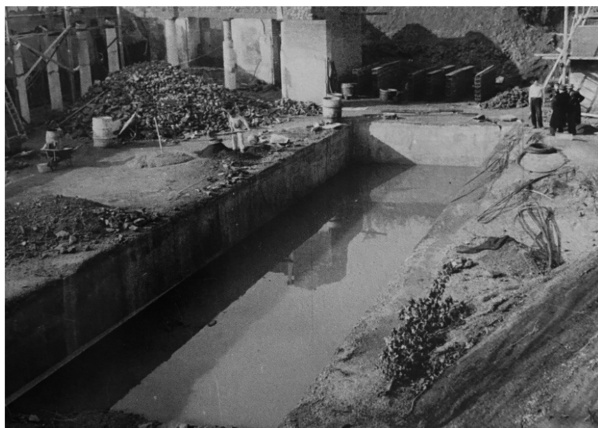
Fig. 4. Peristilio inferiore in corso di scavo. Si notino il cumulo di terra, che occupa l' oculus , non ancora completamente liberato, e i travetti in ferro accumulati pronti per l'armatura dei solai, foto 1952. Da FERRARA 1991, fig. 9.
