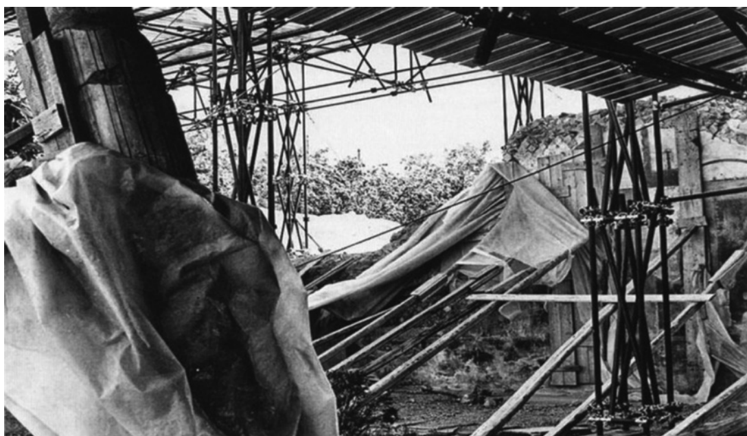
Fig. 9. Braccio sud del peristilio inferiore in seguito ai crolli causati dal terremoto del 1980. Si notino le impalcature da sostegno agli elementi in fase di crollo, foto 1983. Da ALLROGGEN-BEDEL et.al 1983, fig. 3.
