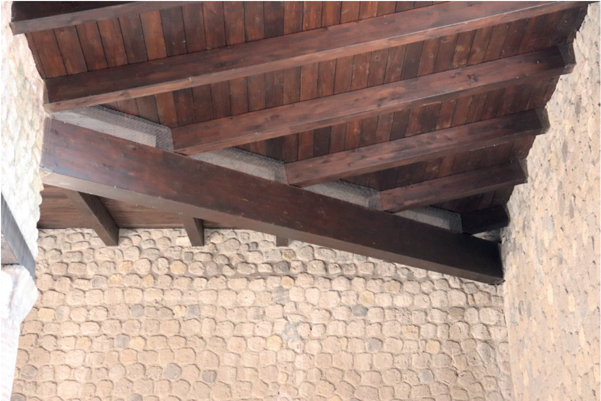
Fig. 10. Copertura dell'atrio con struttura in legno lamellare, realizzata durante i lavori tra il 2010 e il 2012 (foto dell'autore 2019).
