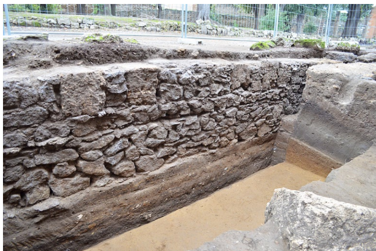
Fig. 9. Pompei, Foro Triangolare. Struttura di fondazione del portico e sottofondazione in terra costipata al di sotto di essa (foto Autori).
