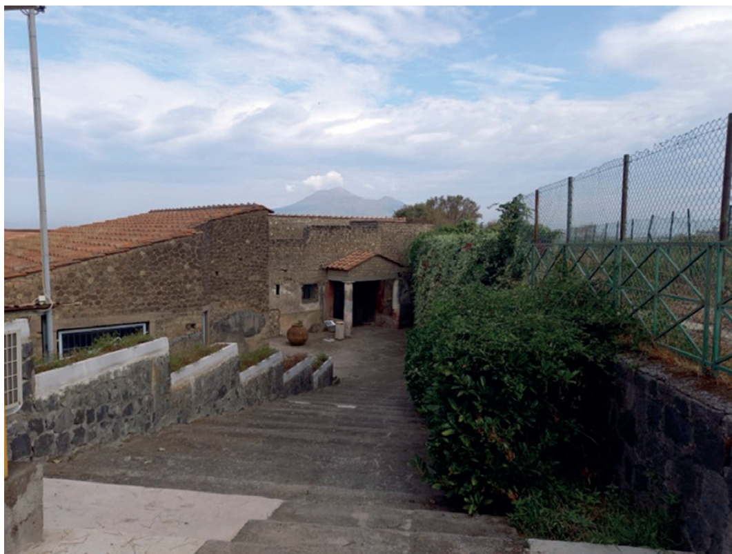
Fig. 6. Area di accesso a Villa San Marco.
