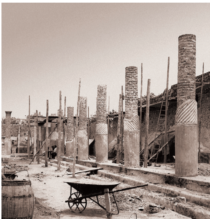
Fig. 7. Il peristilio superiore di Villa San Marco con il porticato a colonne tortili in fase di restauro (su concessione dell'Archivio Comitato per gli scavi di Stabiae fondato nel 1950).
